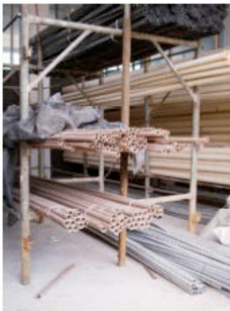
Figura 30: Figura 9 – Estaleiro de Tubos (FREITAS, 2011)
