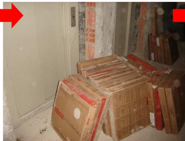
Figura 8 A- cerâmicas em frente ao elevador para serem levadas até local de assentamento. Transporte vertical.
