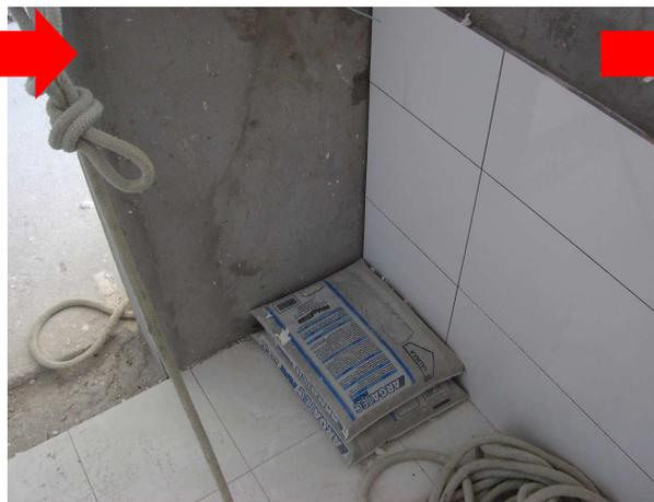
Figura 14 A- armazenagem de argamassa no local correspondente ao assentamento.
