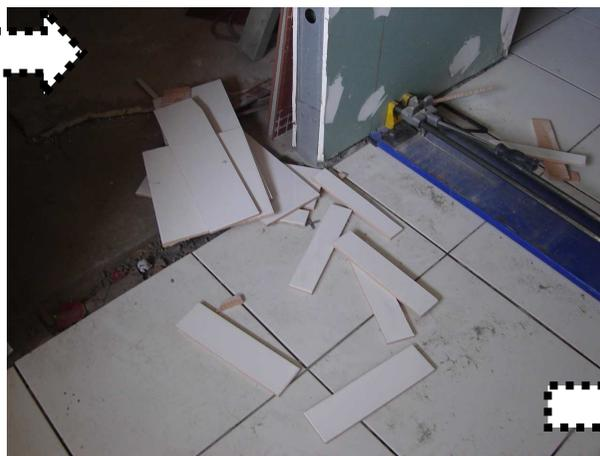
Figura 26 A- policorte e resíduos de cortes; apenas um funcionário está usando o equipamento.
