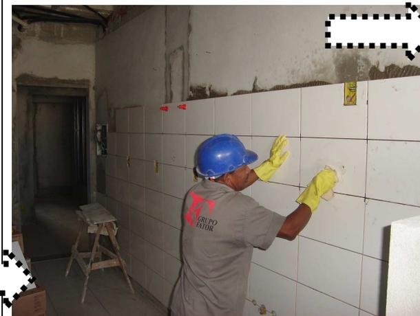
Figura 21 A- assentamento da cerâmica em cozinha; mostrando o assentamento da peça.
