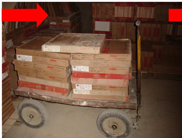
Figura 7 A- preparação das cerâmicas para transporte interno até o local de assentamento. Transporte horizontal.
