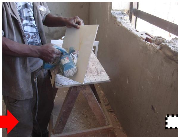
Figura 23 A- corte sendo realizado em placa cerâmica, no meio da peça.
