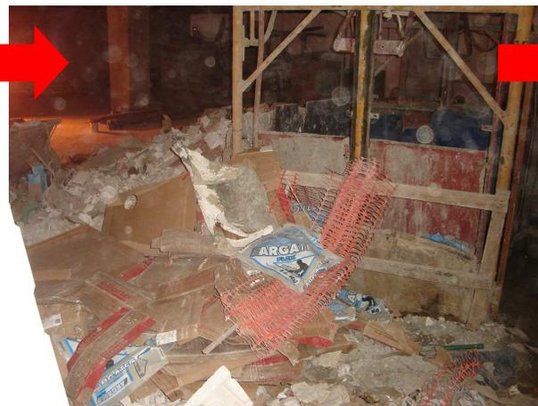
Figura 35 A- resíduos após serem transportados na balança. Não há uma separação por tipo.
