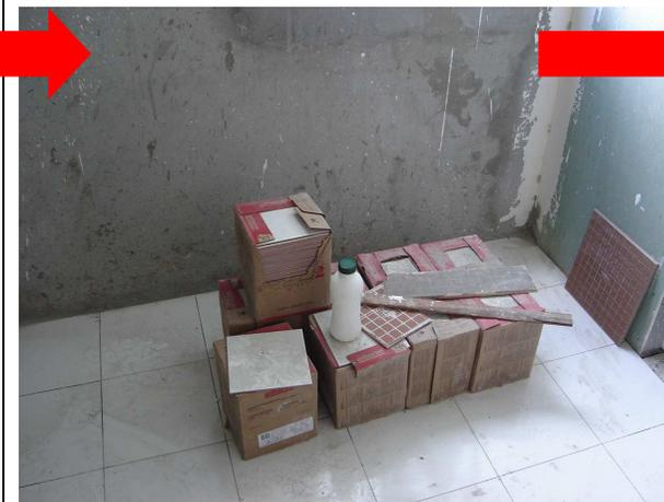
Figura 15 A- armazenagem das cerâmicas no local correspondente ao assentamento.
