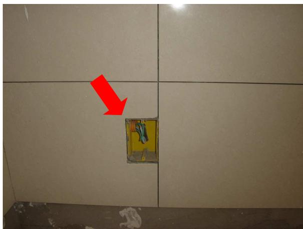
Figura 1B- exemplo de como o projeto de instalações elétricas pode gerar perdas de cerâmicas. O posicionamento na placa dificulta o corte e pode vir a danificá-la.
