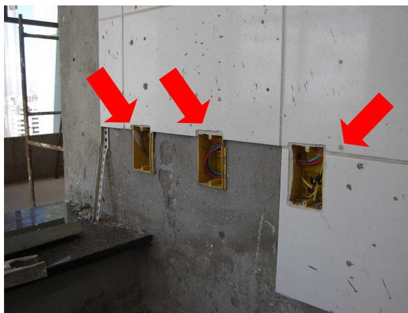
Figura 2B- outro exemplo de como o projeto de instalações elétricas pode gerar perdas de cerâmicas. O posicionamento na placa dificulta o corte e pode vir a danificá-la.
