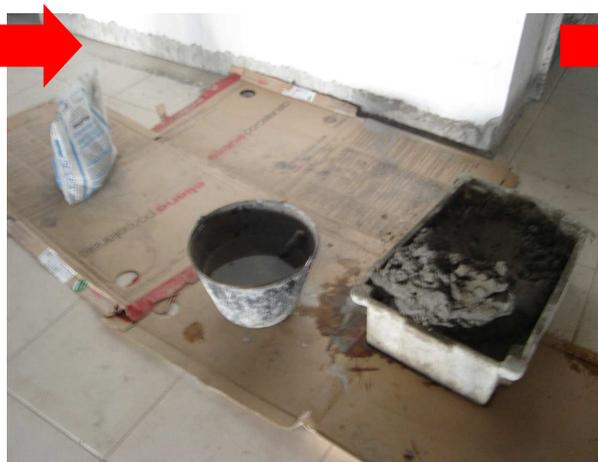
Figura 17 A- exemplo de argamassa sendo preparada no local do assentamento.
