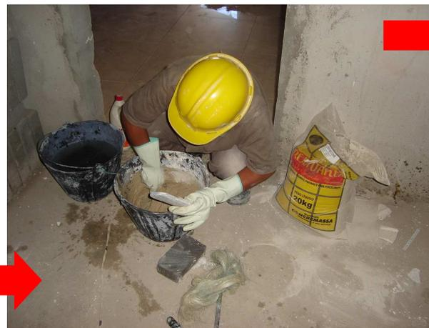
Figura 29 A- preparação do rejuntamento em quantidade suficiente para o serviço.
