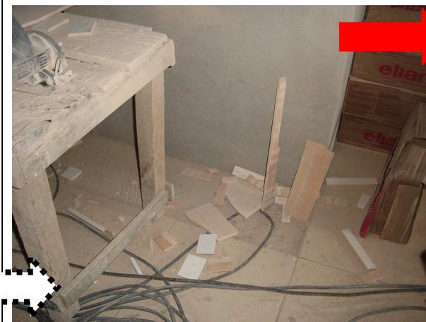
Figura 27 A- bancada servindo de central de corte para todos funcionários que estão no pavimento e resíduos de cortes.
