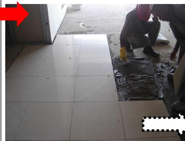
Figura 18 A- assentamento da cerâmica em living; mostrando a aplicação da argamassa.
