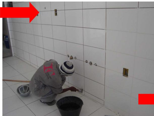
Figura 28 A- limpeza de cerâmicas já assentadas; está sendo retirado o excesso de massa nas juntas e eventuais sujeiras nas cerâmicas.
