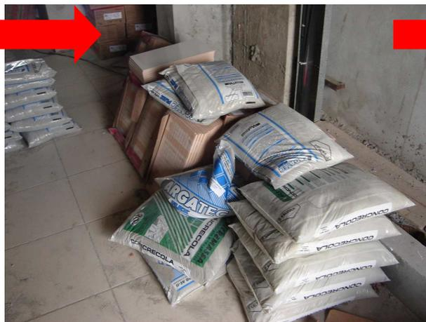
Figura 13 A- armazenagem temporária em frente ao elevador no pavimento onde ocorrerá o serviço.
