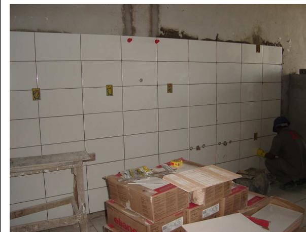
Figura 3B- cortes nas placas cerâmicas nas mais variadas posições demonstra como os projetos de instalações elétricas mão levam em conta a modulação das cerâmicas.
