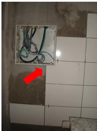
Figura 4B- mais um exemplo de corte em cerâmica gerado pelo projeto de instalação elétrica.
