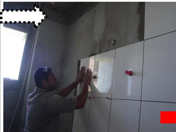
Figura 22 A- assentamento da cerâmica em banheiro; mostrando o assentamento da peça.
