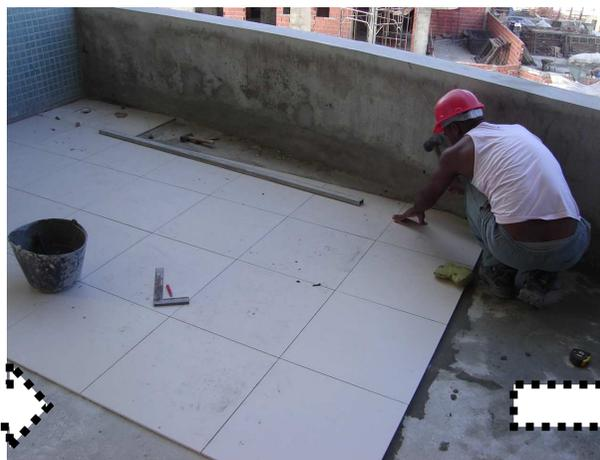
Figura 20 A- assentamento da cerâmica em varanda; mostrando o assentamento da peça.
