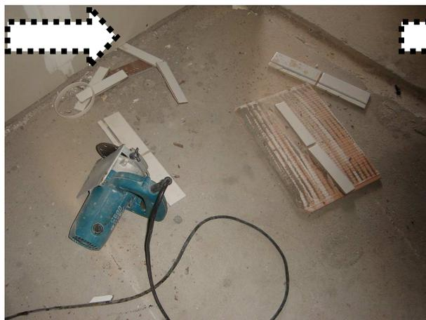
Figura 25 A- maquita e resíduos de cortes; apenas um funcionário está usando o equipamento.
