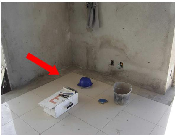
Figura 11B- exemplo de como o projeto arquitetônico pode ajudar nas perdas; o ambiente não foi pensado junto com o revestimento, gerando cortes nas cerâmicas.
