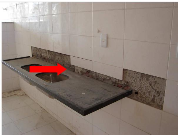
Figura 13B- corte de peças para instalação do rodopia e quebra de peças já assentadas no processo de instalação da bancada.
