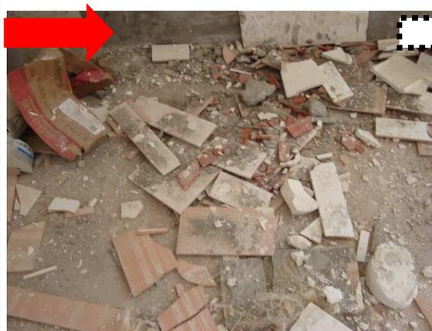
Figura 31 A- ambiente interno a apartamento sendo usado para "depósito" de resíduos para posterior recolhimento. Não há uma separação de materiais.
