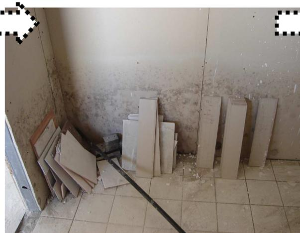
Figura 32 A- ambiente interno a apartamento sendo usado para "depósito" de resíduos. Aqui os resíduos encontram-se separados e arrumados.
