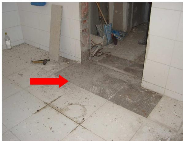
Figura 14B- retrabalho ocasionado pelo gerenciamento inadequado de serviços. Perdeu-se peças cerâmicas durante a instalação da soleira.
