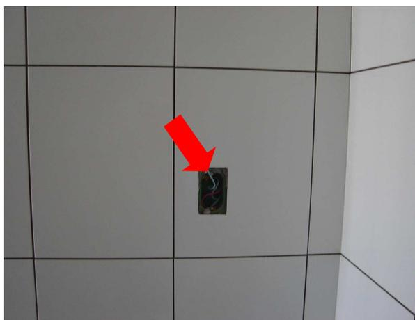
Figura 8B- posicionamento da caixinha dificultando ainda mais o corte da peça.
