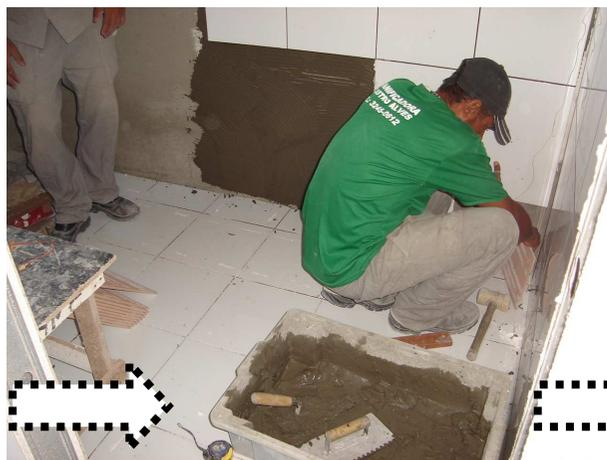
Figura 19 A- assentamento da cerâmica em banheiro; mostrando a aplicação da argamassa.
