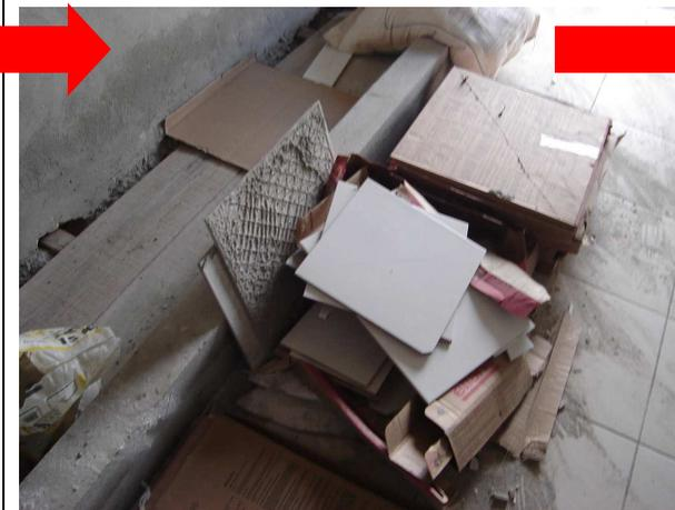
Figura 12 A- peças cerâmicas que foram quebradas durante transporte até o local de assentamento.
