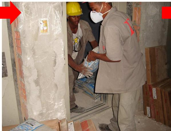
Figura 11 A- sacos de argamassa sendo colocados no elevador para serem transportados até local de assentamento.
