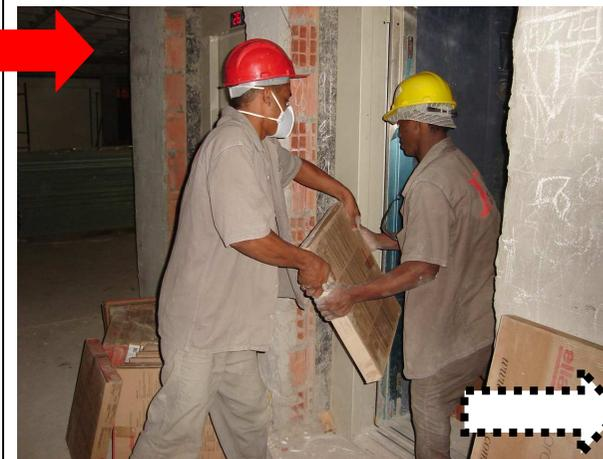
Figura 9 A- cerâmicas em frente ao elevador para serem levadas até local de assentamento. Transporte vertical.
