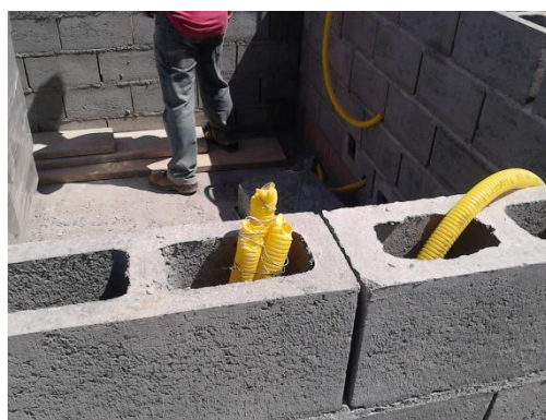
Figura 50 - Passagem de Eletrodutos
