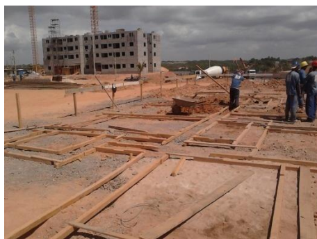
Figura 43 - Gabarito de marcação viga.
