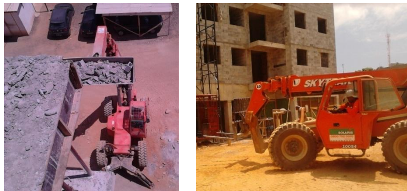
Figura 20 - Transporte de Componente e Retirada de Entulho.
