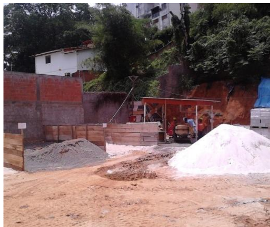
Figura 24 - Estocagem de agregados.
