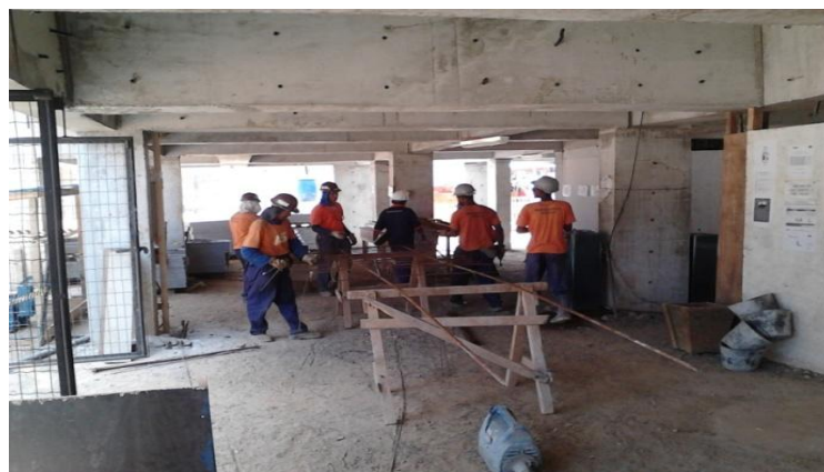
Figura 18 - Volume de vigas e pilares.
