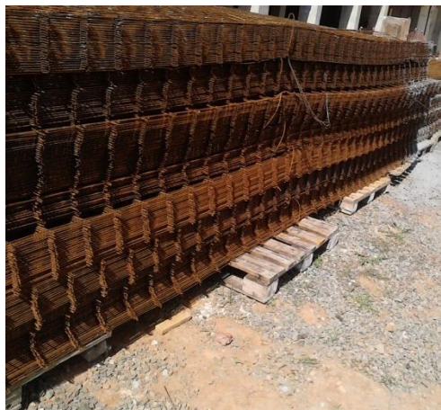
Figura 23 –Estocagem de armadura
