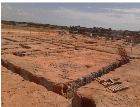
Figura 44 - Corte em terreno p/ execução viga.
