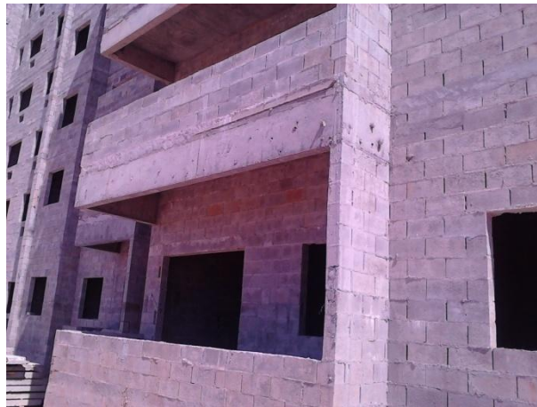
Figura 40 - Viga Pré-moldada inserida no sistema
