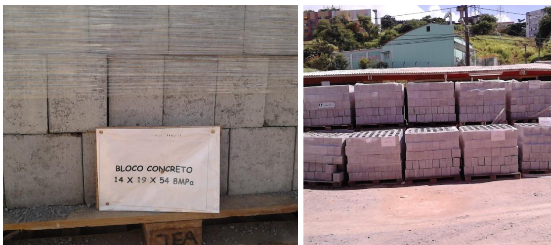
Figura 22- Armazenamento de Blocos e identificação.
