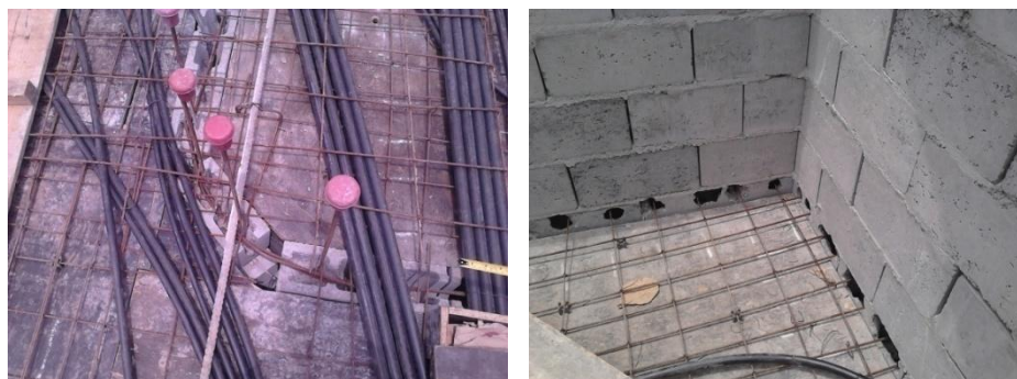
Figura 21 - Forma da laje e de patamar de escada a ser concretada.
