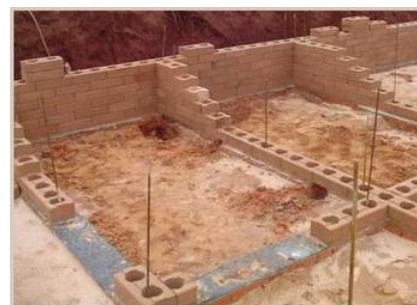
Figura 5 – Alvenaria no nível do solo (fonte:GOOGLE,2010)
