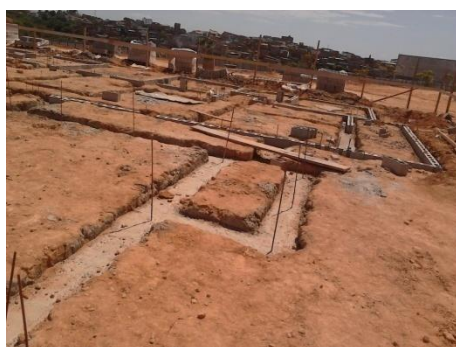
Figura 45 - Viga baldrame concretada.
