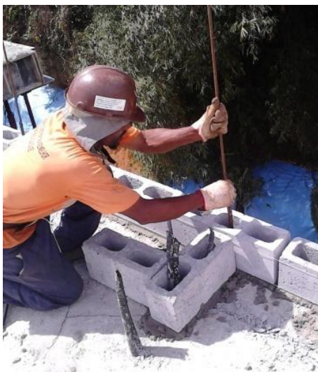
Figura 27 - Transpasse da armação, Transpasse dos eletrodutos e disposição de planta de locação.
