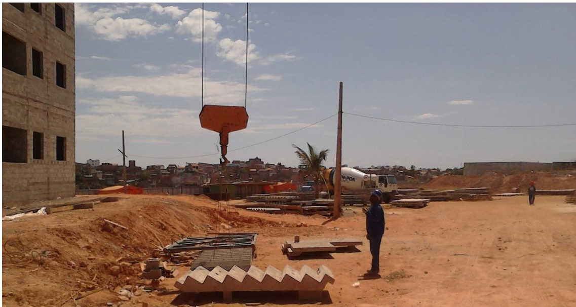
Figura 41 - Içamento de escada Pré-moldada
