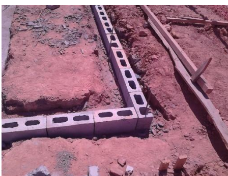
Figura 46 - 1º sobre viga baldrame
