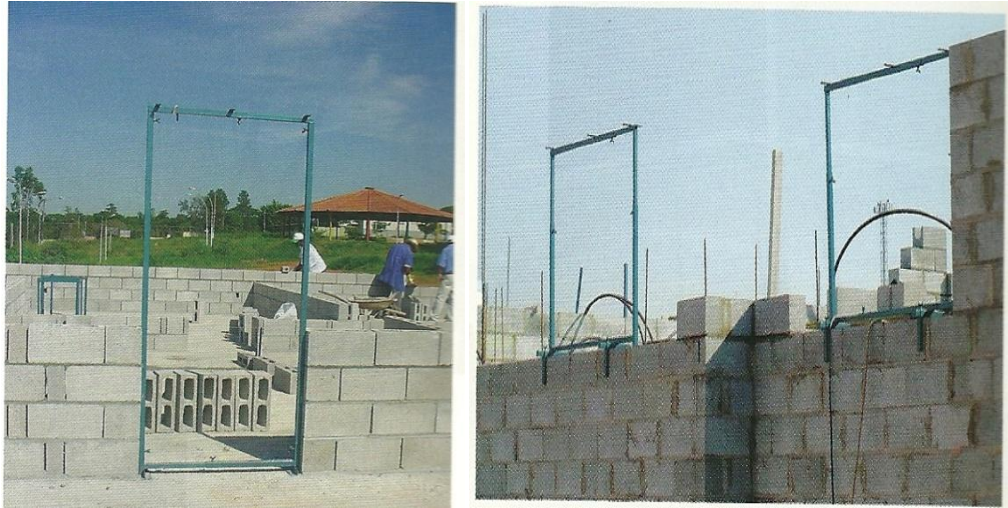
Figura 16 - Gabaritos para vãos. (fonte : Tauil, 2010)
