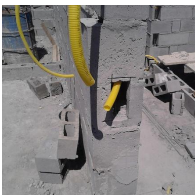
Figura 49 - Rasgo para caixa de passagem
