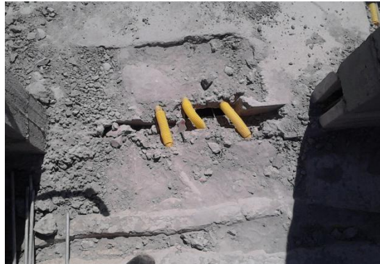
Figura 51 - Conção de instalações entre lajes pré-moldadas
