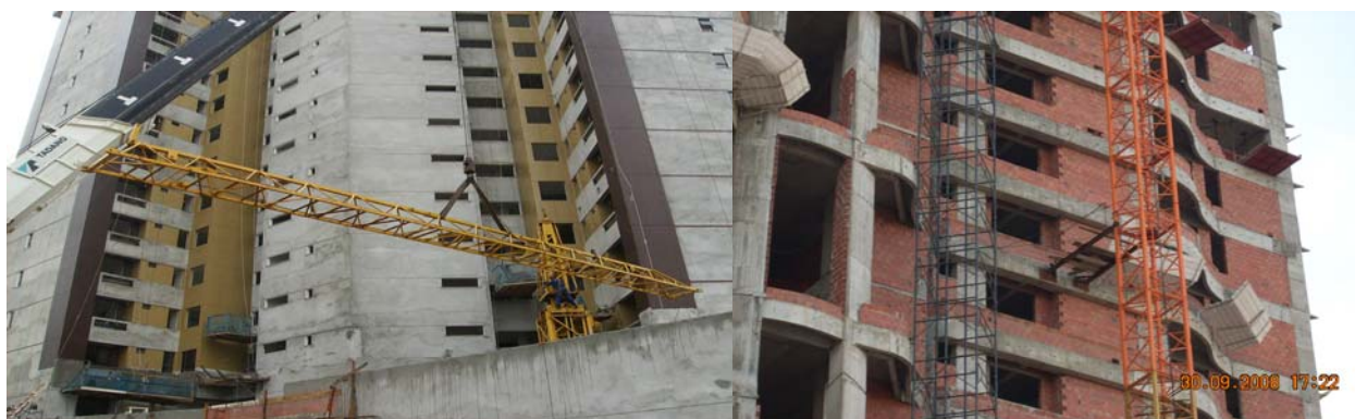
Figura 07. Imagens de desmontagem e passarela para grua.
