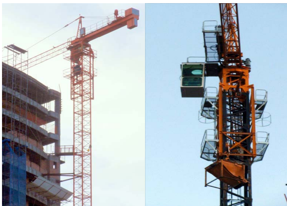
Figura 08. Imagens de gruas das obras 14 e 18.
