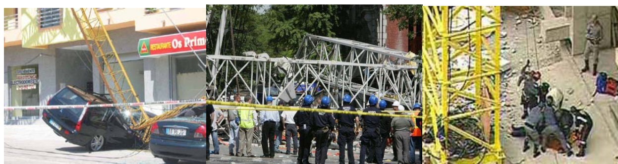
Figura 04. Imagens de acidente com a utilização do guindaste.
