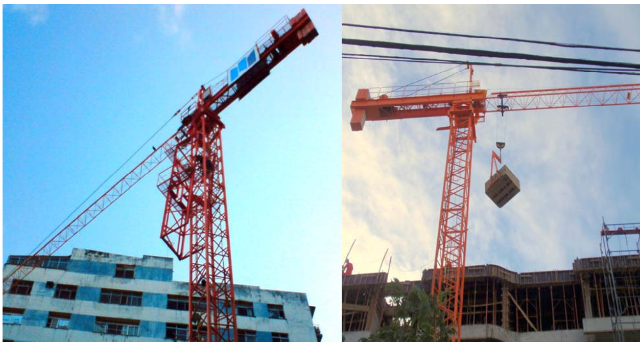
Figura 10. Imagens da obra 31 e obra 10.
