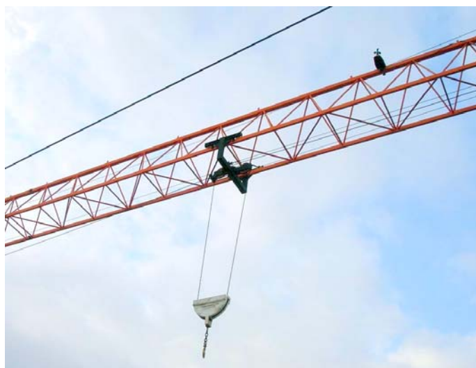
Figura 11. Anemômetro na grua da obra 14. Fonte: Própria autora.
