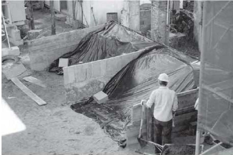
Figura 51 – Contenções laterais e lona de cobertura em baia de agregados
