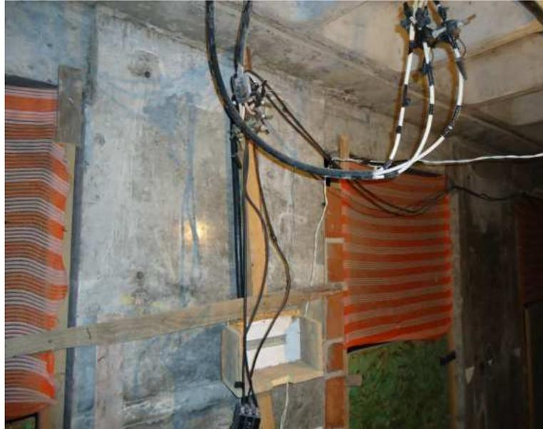
Figura 15 – Instalações provisórias de energia sem sinalização
