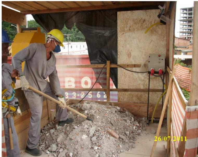
Figura 13 – Dificuldade do lançamento no receptor do triturador.
