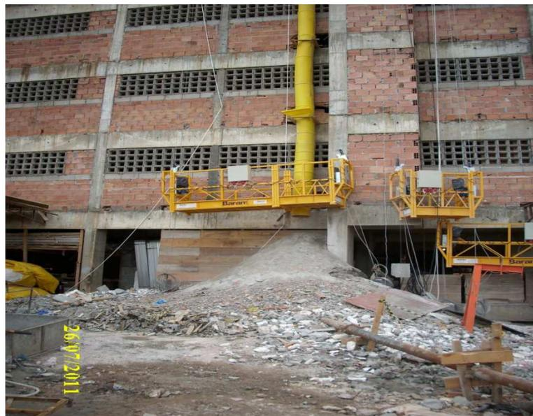
Figura 8 – Entulho descarregado pelo tubo coletor diretamente no canteiro
