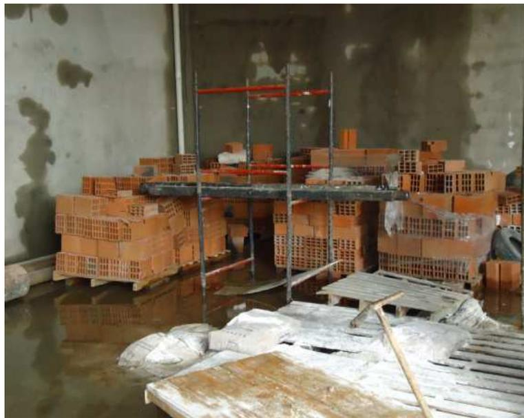
Figura 18 – Armazenamento de blocos cerâmicos
