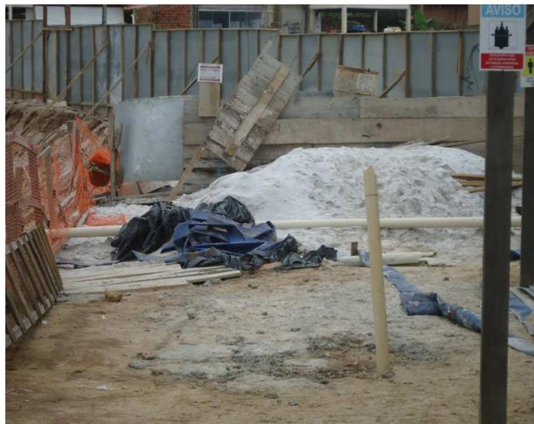
Figura 38 – Armazenamento inadequado da areia
