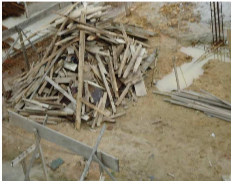
Figura 39 – Armazenamento inadequado dos resíduos sólido
