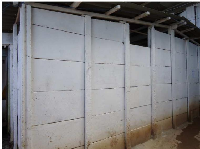
Figura 46 – Áreas de vivência com placas de concreto
