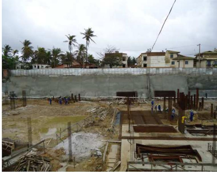
Figura 30 – Contenção de talude
