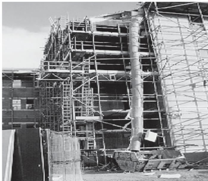
Figura 50 – Tubo coletor de entulho, associado a caçamba basculante
