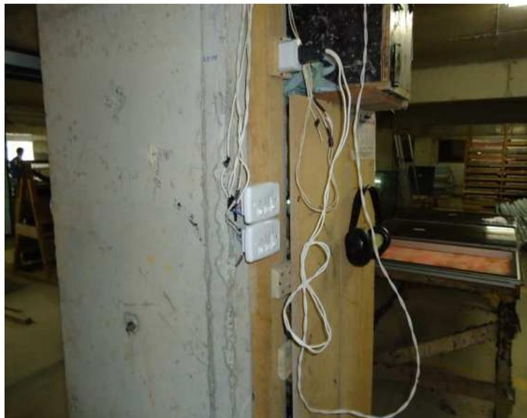
Figura 16 – Instalações provisórias com risco de acidente.
