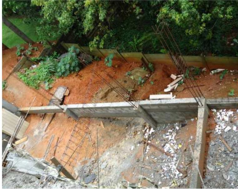
Figura 30 – Contenção de desmoronamento
