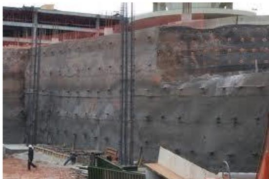
Figura 4.16 - Contenção permanente em solo grampeado.
