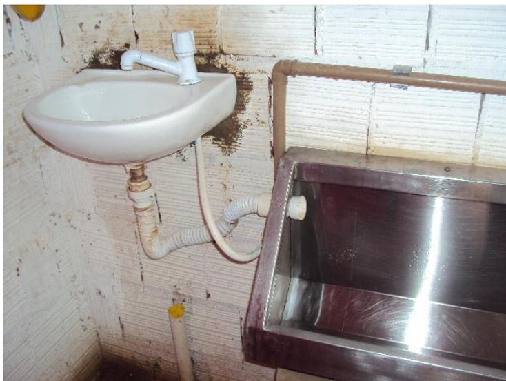
Figura 3.1 - Exemplo de redução do impacto ambiental em canteiro de obras em Fortaleza/CE, com a utilização da água utilizada para lavar as mãos sendo reaproveitada para limpar o mictório.
