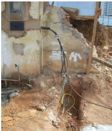
Figura 4.9 - Ligações provisórias desprotegidas.
