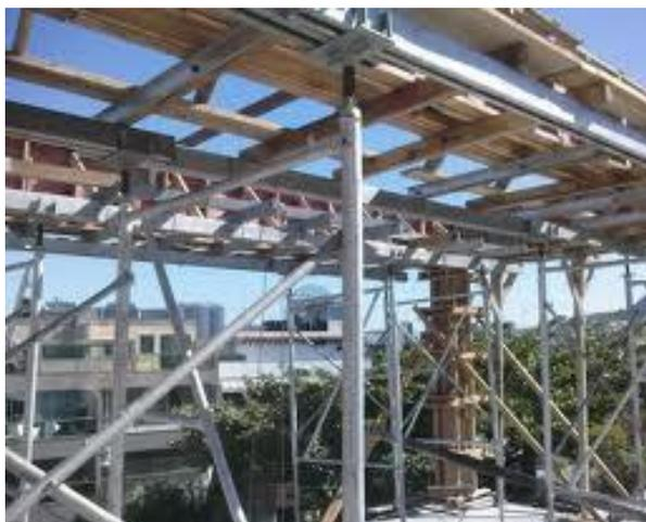
Figura 4.20 - Formas em madeira com escoramento metálico.
