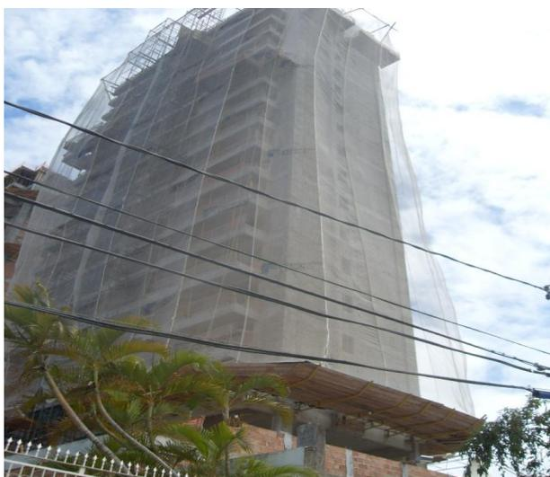
Figura 4.36 - Uso de telas de proteção e bandejas.
