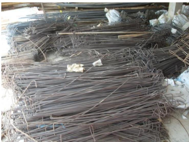
Figura 4.26 - Armazenagem de ferragem de forma inadequada.
