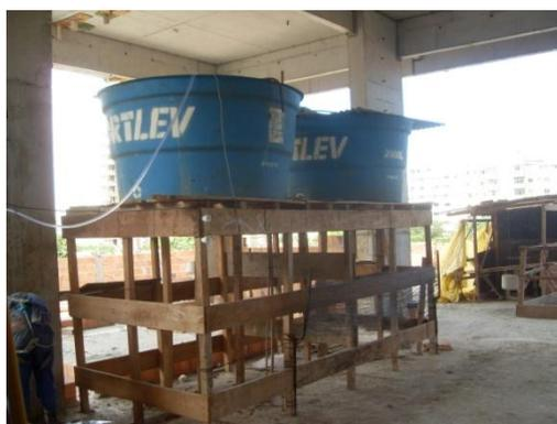
Figura 4.33 - Reservatórios de água embaixo de laje da torre.
