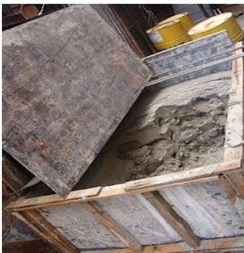
Figura 4.22 - Armazenagem da argamassa industrializada.
