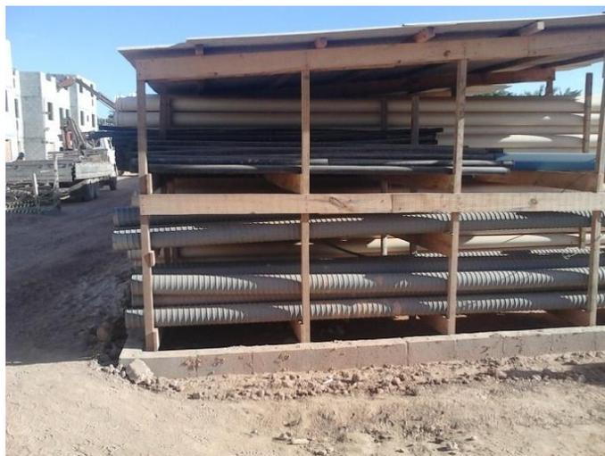
Figura 4.31 - Construções provisórias para depósito de materiais.
