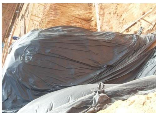
Figura 4.8 - Talude mal protegido.
