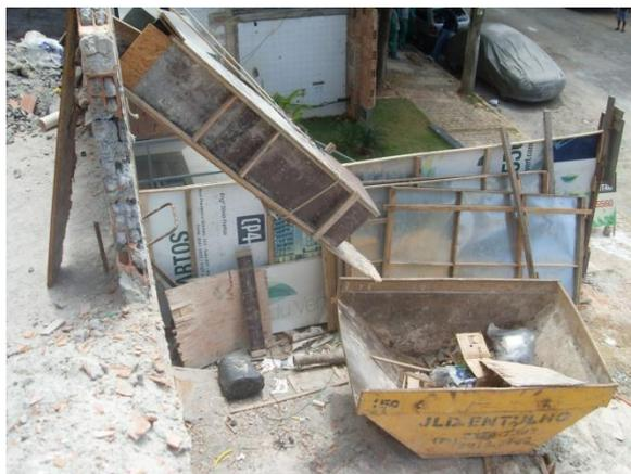
Figura 4.38 - Exemplo de descarte de resíduos, sem separação adequada.
