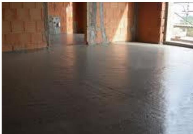
Figura 4.35 - Uso de contra piso autonivelante.
