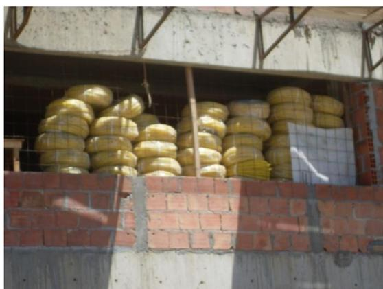
Figura 4.7 - Uso de área edificada para depósito de materiais.
