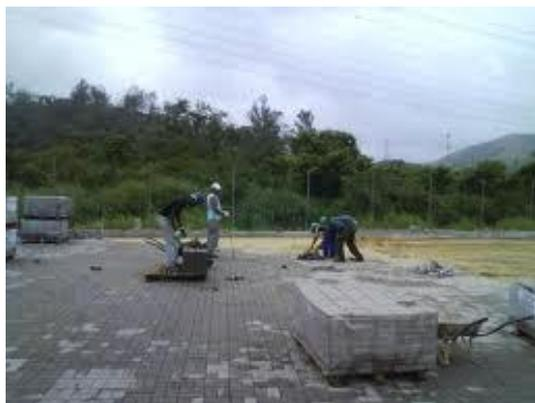
Figura 4.17 - Piso em bloco intertravado.
