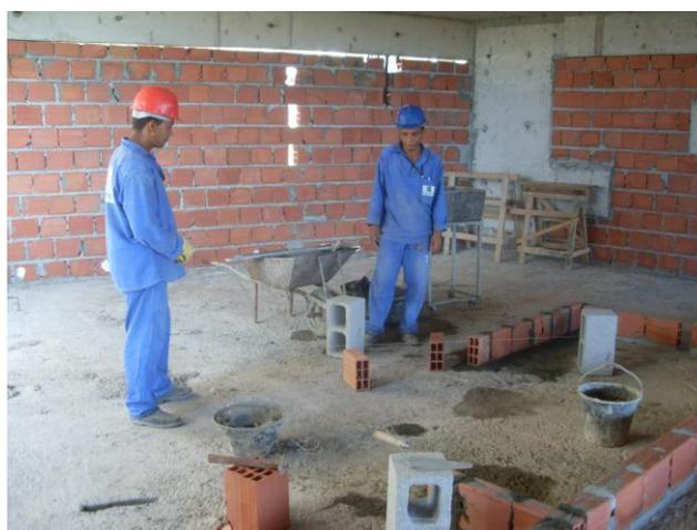
Figura 4.21 - Alvenaria com diferentes tamanhos de blocos.
