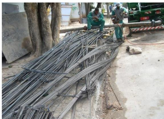
Figura 4.10 - Compra de material dobrado inadequadamente armazenado na via publica.
