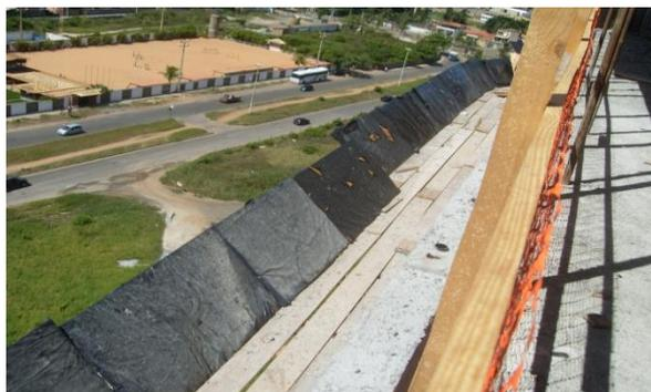
Figura 4.15 - Utilização de bandejas de proteção
