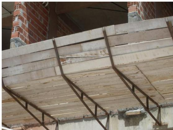
Figura 4.34 - Uso de bandejas de proteção contra quedas.
