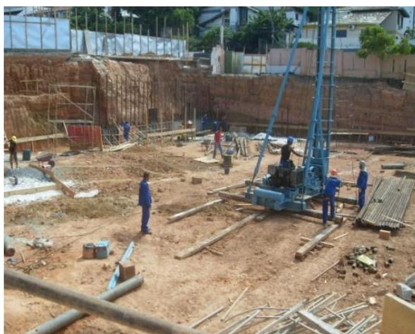
Figura 4.27 - Uso de bate estaca de martelo de queda livre.
