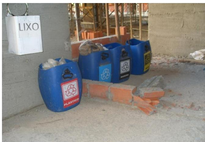
Figura 4.2 - Material separado para coleta.
