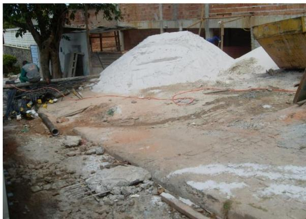
Figura 4.32 - Exemplo de material mal disposto, praticamente dentro da via, conseqüência do canteiro compacto, e de ferragens adquiridas cortadas e dobradas.
