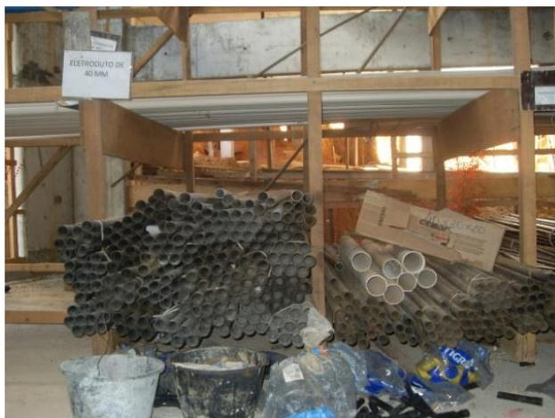
Figura 4.24 - Uso de área edificada em substituição as provisórias para depósito
