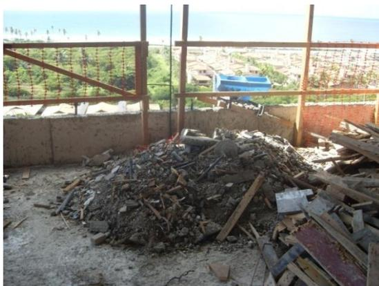
Figura 4.12 - Separação do entulho no pavimento de origem.
