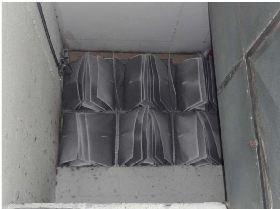
*Figura 35 - Sistema de entrada de ar do edifício associada ao uso de filtros*
