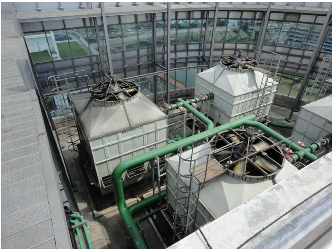
*Figura 45 - Torre de resfriamento do sistema de ar condicionado*
