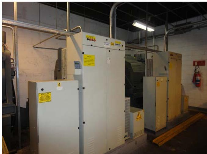
*Figura 31 - Equipamentos referente ao sistema de frenagem regenerativa dos elevadores*
