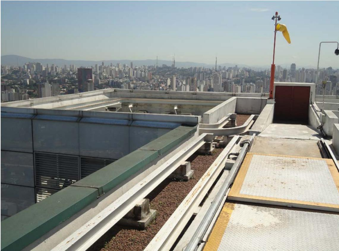
*Figura 39 - Trilhos metálicos para trânsito das gôndolas para limpeza da fachada*
