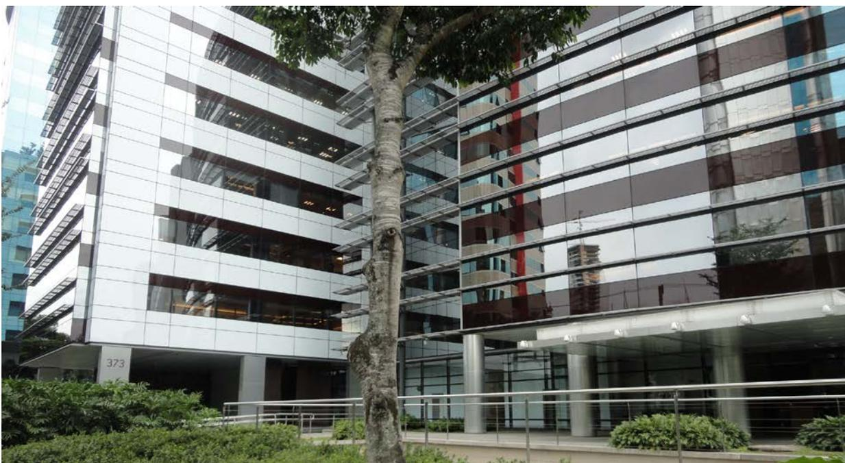
*Figura 41 - Vista da fachada norte, com detalhe dos brises*
