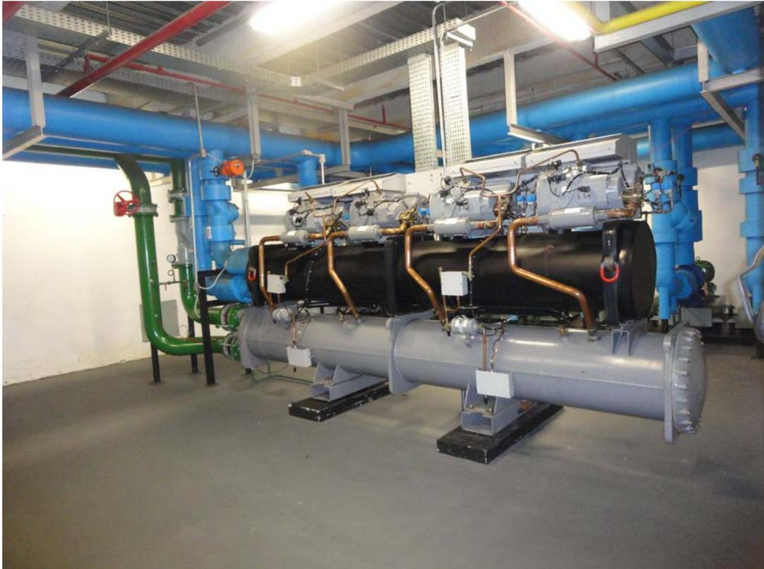
*Figura 46 - Chillers para condicionamento de ar*
