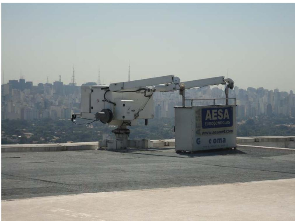
*Figura 38 - Gondola para limpeza da fachada*
