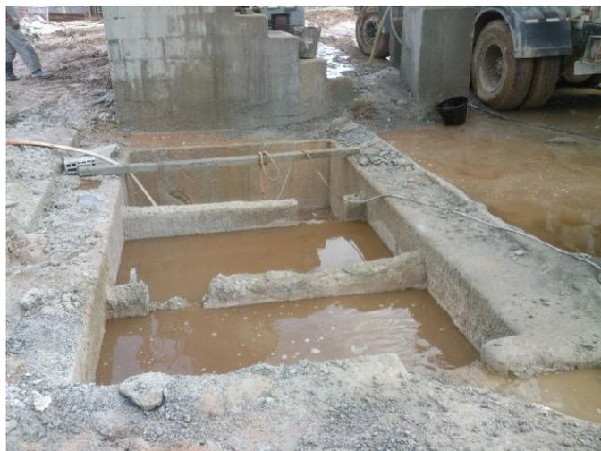
Figura 03 – Tanque de decantação – Obra A
