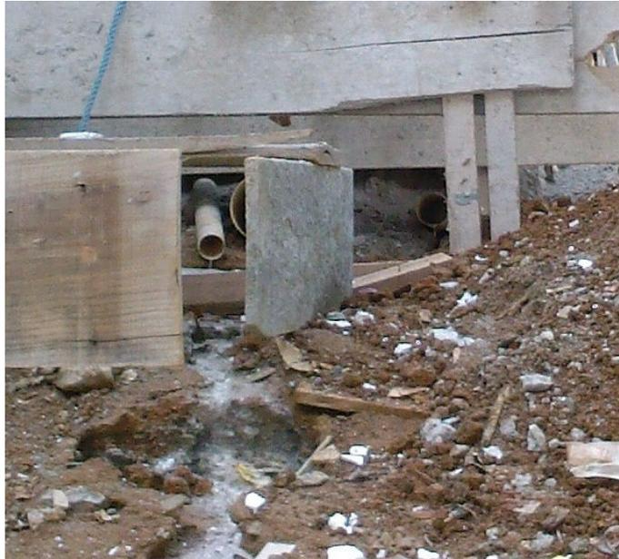
Figuras 44 – Efluentes Líquidos lançados no terreno – Obra D
