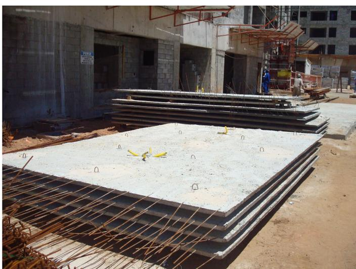
Figuras 57 – Laje pré-moldada em concreto armado – Obra E
