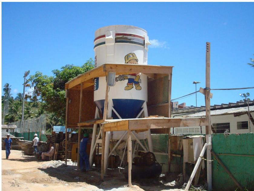
Figuras 56 – Silo para argamassa projetada – Obra E
