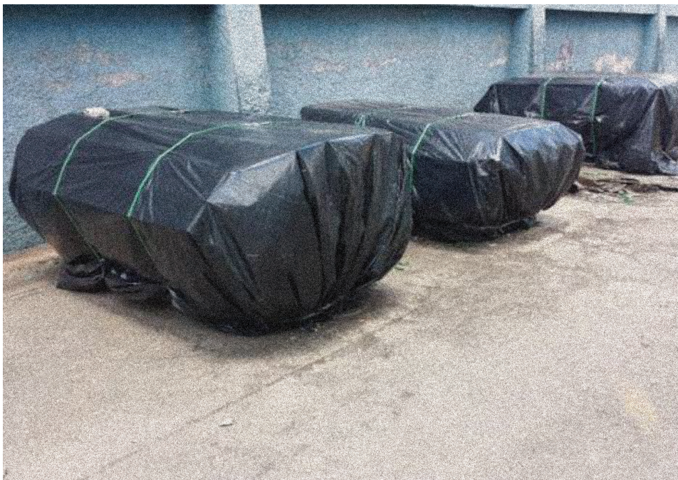
IMAGEM 1 • Telhas de Amianto separadas para tratamento especial.
