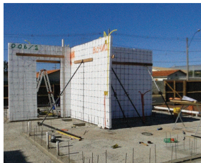
FOTOGRAFIA 13 • Fixação dos painéis.
