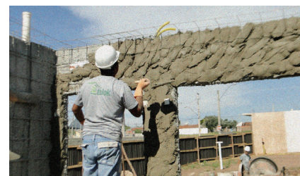
FOTOGRAFIA 17 • Aplicação do emboço
