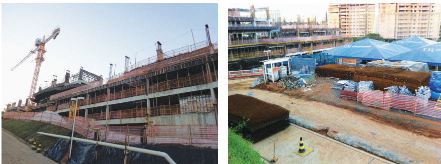
FIGURA 3 E 4 • Uso de escoramento em diversos pavimentos simultaneamente; necessidade de grande área para armazenamento de insumos da estrutura.
