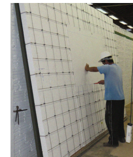
FOTOGRAFIA 7 • Colocação da malha de aço.
