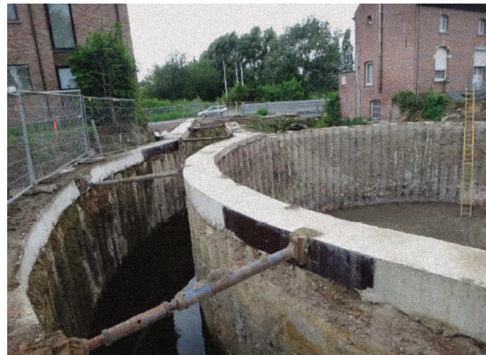
FIGURA 8 • Vista lateral de tanque submerso executado em estacas secantes (Bélgica). FONTE: FLEURY (2012).
