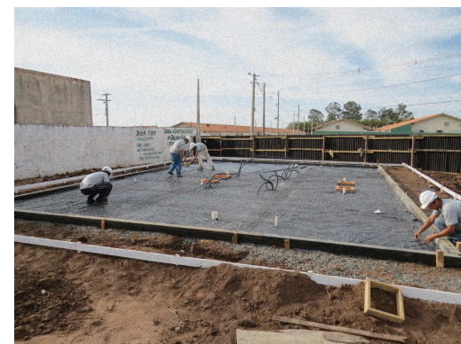
FOTOGRAFIA 12 • Execução da fundação
