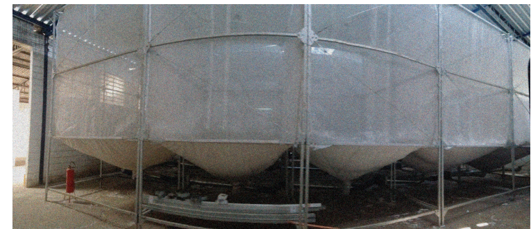
FOTOGRAFIA 3 • SILOS PARA ESTOCAGEM.
