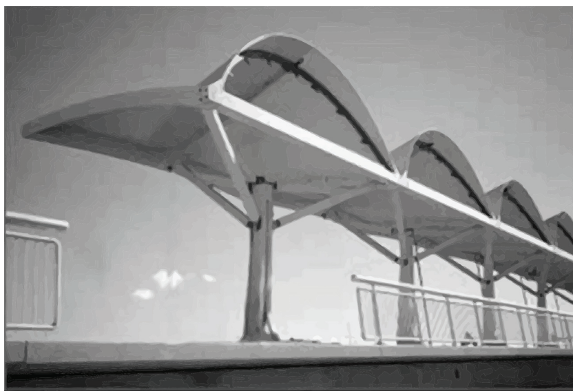
FIGURA 2 • Ponto de ônibus feitos com chapa de CPR em Shawnessy, Canadá.
