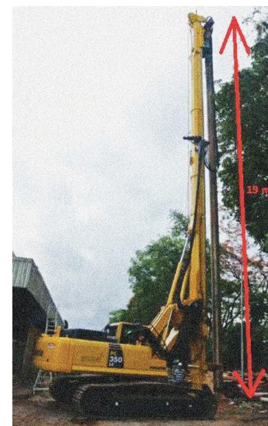
FIGURA 10 • Equipamento que executa estacas secantes com foco no comprimento do tubo.
