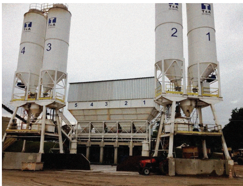
FOTOGRAFIA 1 • Central de concreto da fábrica
