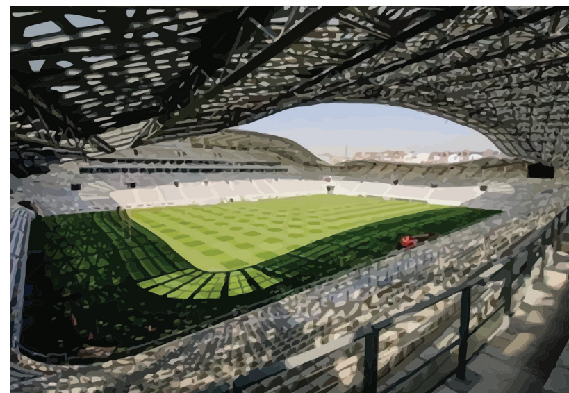
FIGURA 4 • Aplicação de painéis pré-moldados no estádio Jean Bouin na França.
