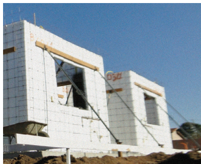
FOTOGRAFIA 14 • Painéis instalados e escorados
