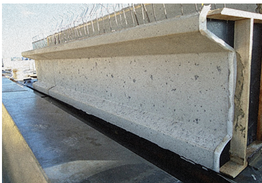
FOTOGRAFIA 2 • Peça Concretada com CCV
