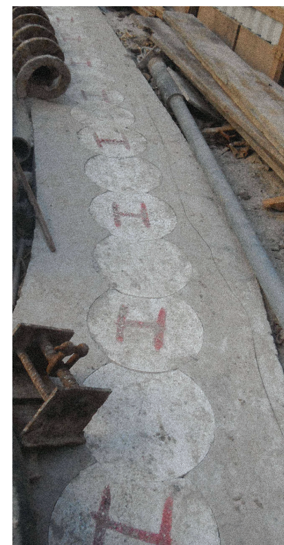
FIGURA 2 • Forma de isopor identificada, e com a mureta concretada.
