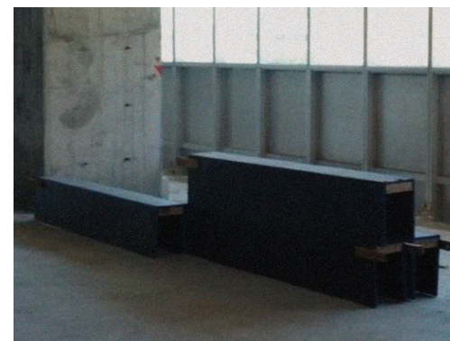
FIGURA 15 • Proteção dos módulos
