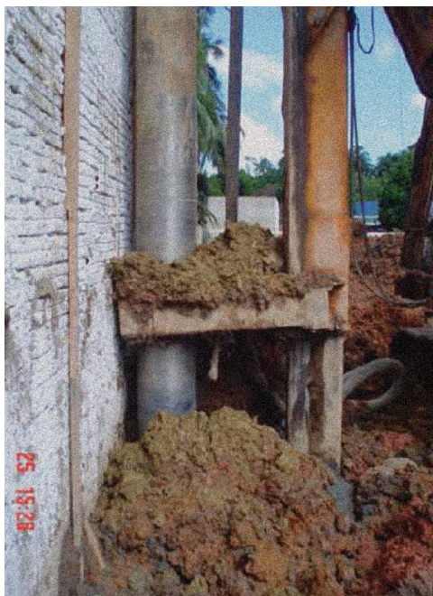
FIGURA 9 • Execução de estacas faceadas à divisa.
