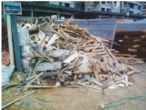
FIGURA 2 • Baía de resíduos de madeira proveniente de fôrmas.
