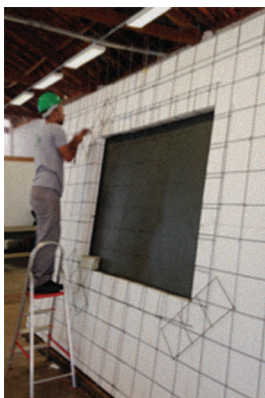
FOTOGRAFIA 8 • Reforço da armadura.
