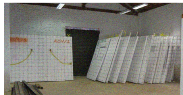
FOTOGRAFIA 11 • Estoque dos painéis prontos
