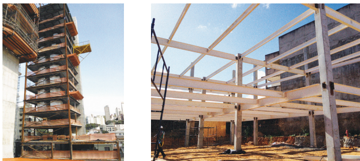
FIGURA 5 E 6 • Hotel Ibis, diversos pavimentos executados sem uso de escoramento, Rede Mix e inexistência de resíduos provenientes da estrutura
