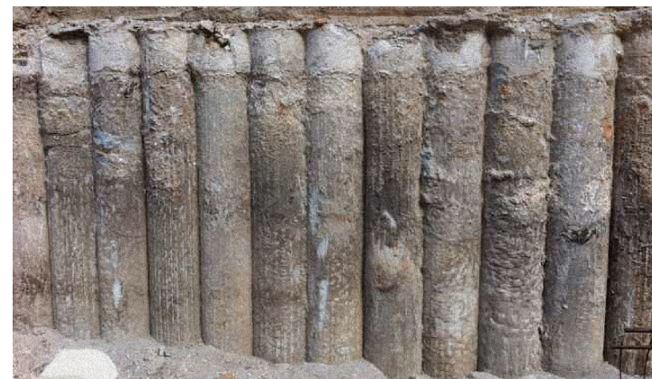
FIGURA 11 • Contenção em estaca secante da obra de Niterói.
