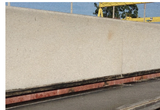
FOTOGRAFIA 3 • Peça Concretada com CAA
