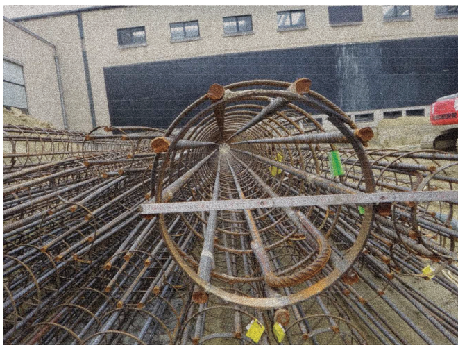
FIGURA 7 • Armação empregada nas estacas secantes. FONTE: FLEURY (2012).
