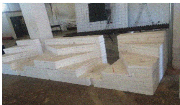
FOTOGRAFIA 10 • Escada feita com sobras de EPS
