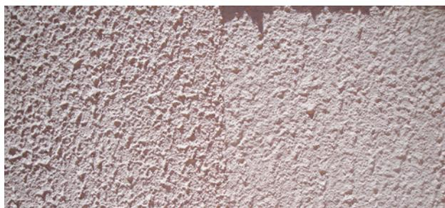
**FIGURA 8** • Diferença de tonalidade em fachada, devido à não padronização do acabamento (acervo do autor)
