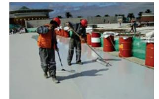
FIGURA 7 • Execução de poliuretano sem aplicação de flakes decorativos (fonte: BASF, 2012)
