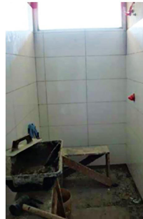
**FIGURA 13 •** Falta de compatibilização dimensional das placas com o ambiente (fonte: Pozenato, 2010)
