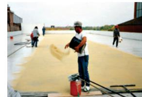
FIGURA 5 • Aspersão manual de quartzo em piso antiderrapante (fonte: BASF, 2012)
