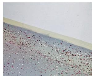
**FIGURA 10 •** Não uniformidade na aplicação do *flake*
