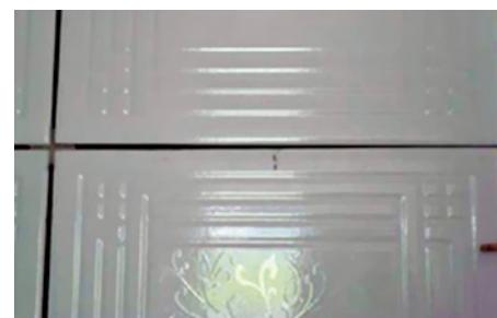
**FIGURA 12 •** Variação dimensional na altura das placas (fonte: Pozenato, 2010)
